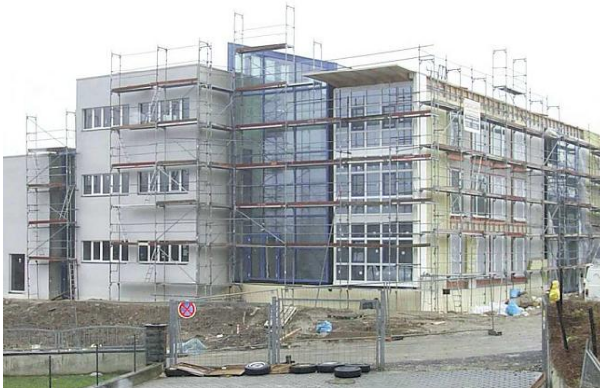
Kuva: Esimerkki, jossa kolme erillistä rakennusta on yhdistetty lasirakenteella yhdeksi kompaktiksi rakennelmäksi. (Lähde: Ökologische Gewerbeberatung Stadt Münster, Gebäudeplanung)
